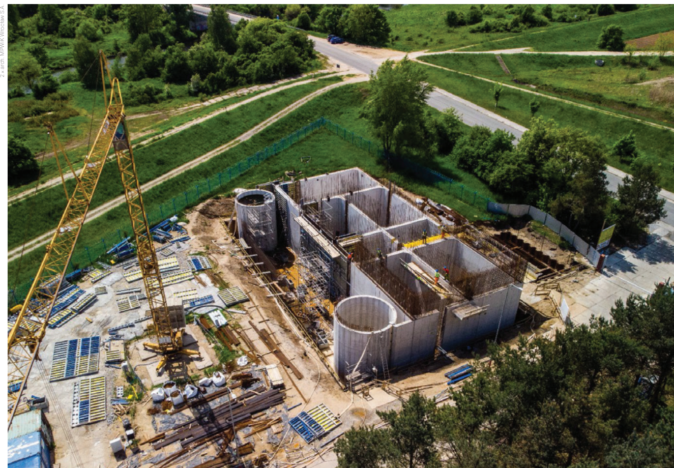
Fot. 1. Obecny stan zaawansowania budowy na koniec II kwartału 2025 reaktora budowanego przez MPWiK Wrocław S.A.
